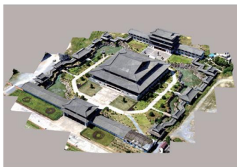
广东某仿古建筑倾斜摄影模型
